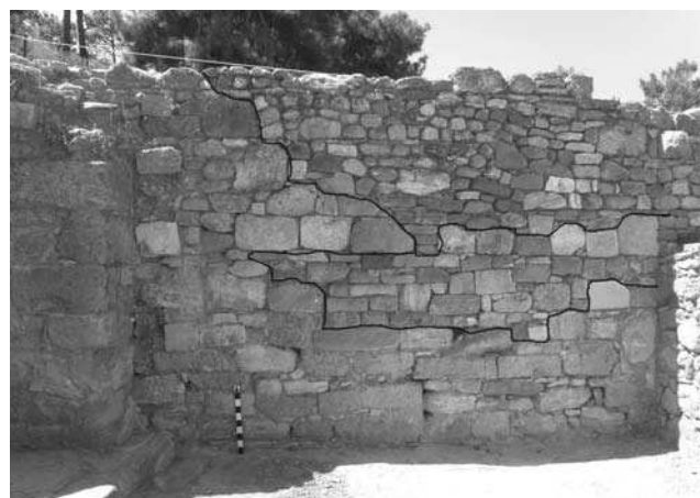
Εικ. 9. Τοίχος στο κτήριο Α1 στο νοτιοδυτικό τμήμα της αγοράς. Απόπειρα διάκρισης των ιταλικών συμπληρώσεων.
