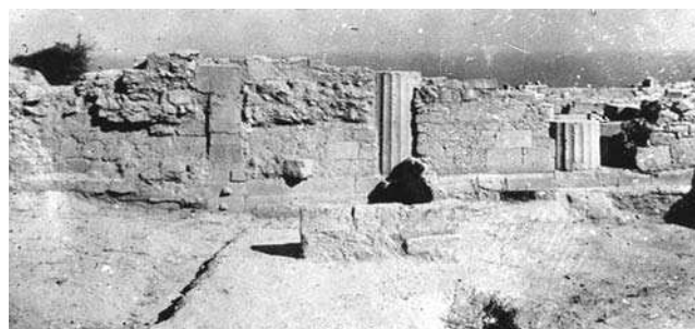
Εικ. 13. Η πρόσοψη του ναού του Απόλλωνος στην αγορά. Τα μετακίονια κλείστηκαν με τοιχοδομία, όταν ο ναός καταργήθηκε και πιθανώς ενσωματώθηκε στο κτήριο Α1, αμέσως δυτικά του.
